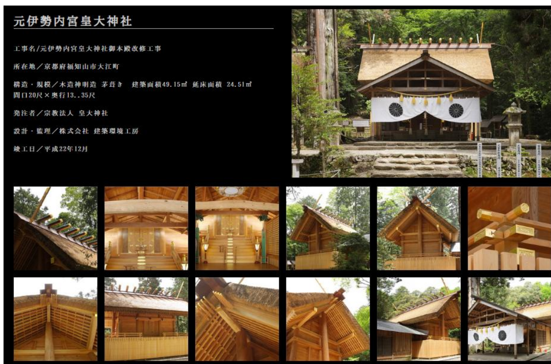
(神田組の施工実績)
